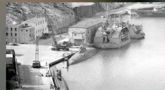
Контрольно-испытательная станция и Стенд
