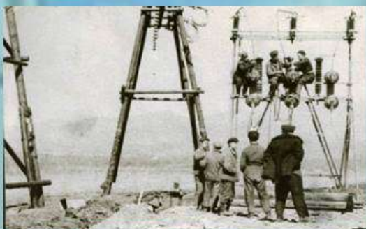
Строительство ЛЭП в Балаклаве
