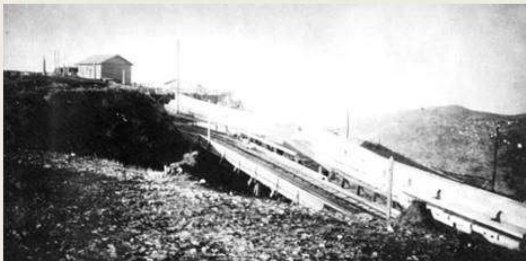
Строительство дороги к фортам
